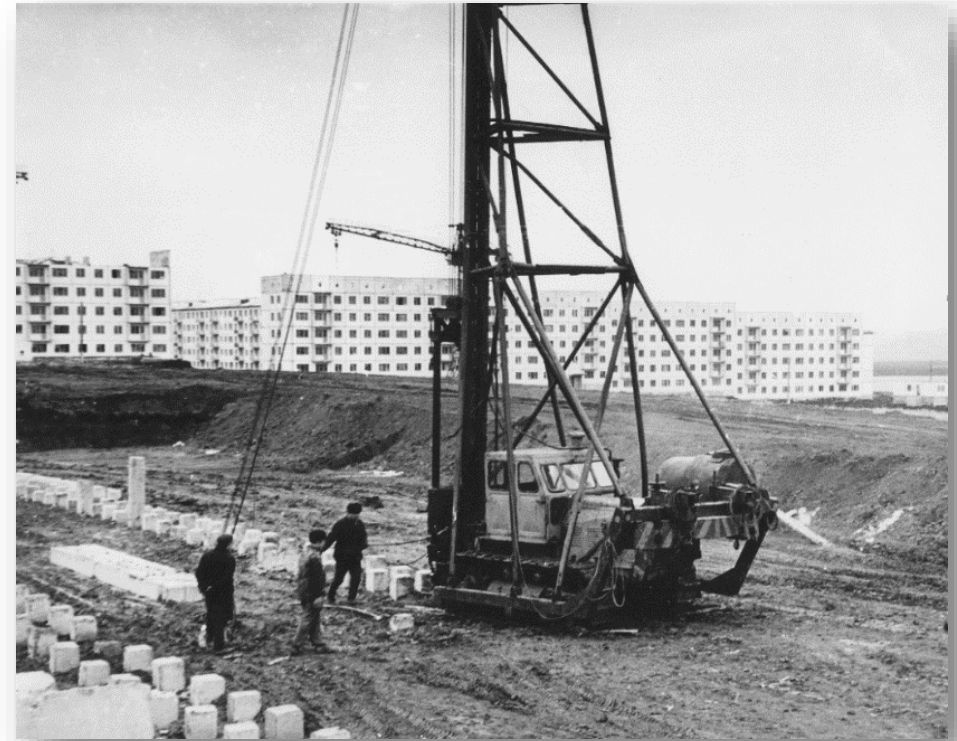
Строительство нового главного корпуса в Ленинском районе
