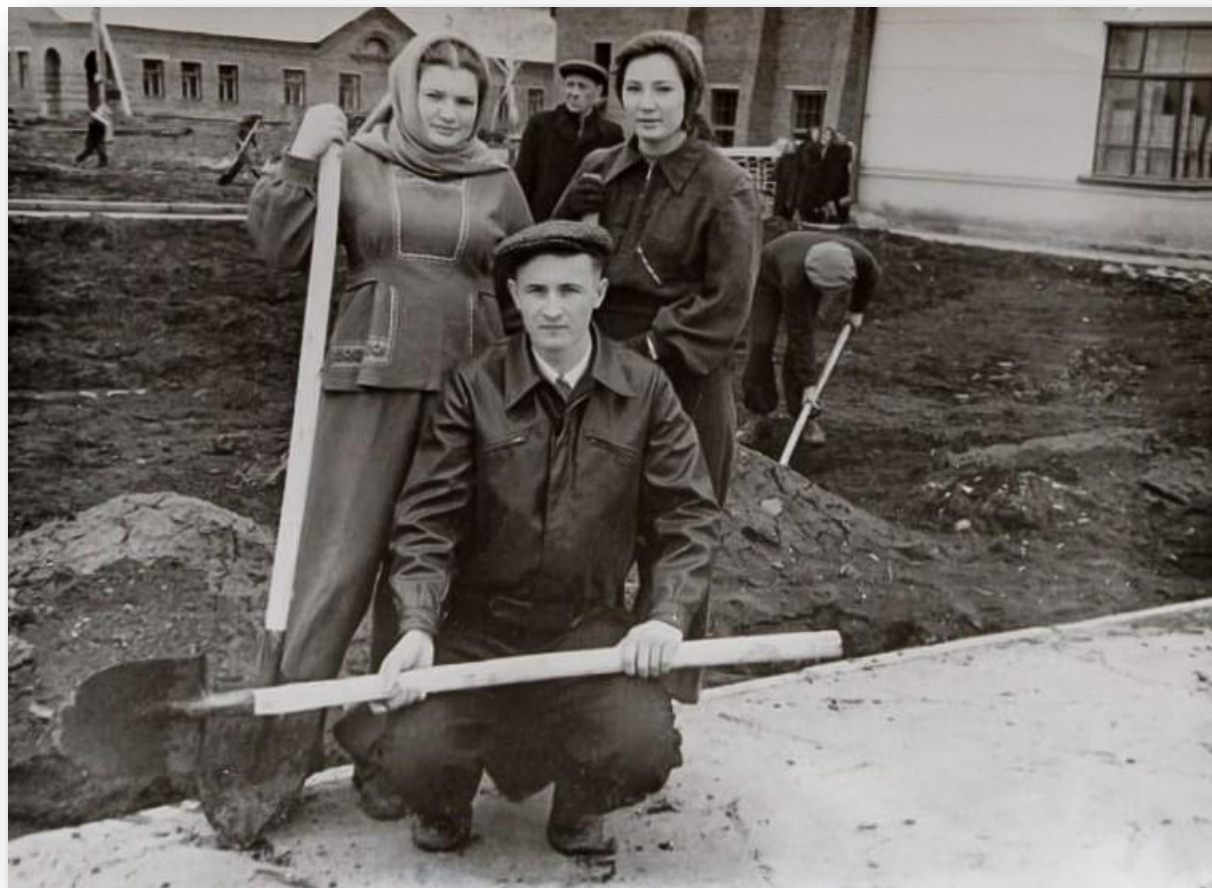
1957 г. студенты (Людмила Возняк, Валерия Королёва-Муниц, Виктор Саушев) копают траншеи для коммуникаций учебного корпуса в Кировском районе
