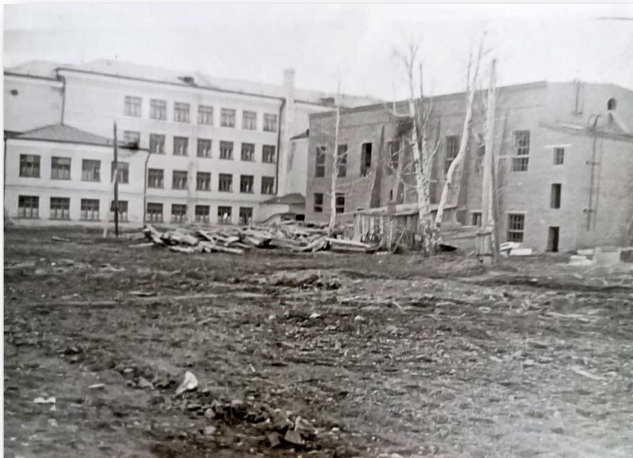
1957 г. Строительство актового и спортивного залов в Кировском районе
